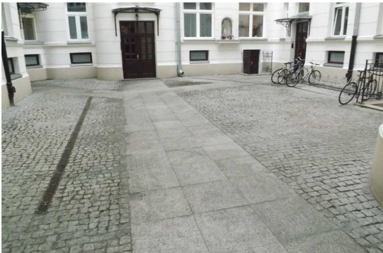
Rys. 12. Widok podwórka po wymianie płyty stropowej nad piwnicami, wymianie izolacji i warstw nawierzchniowych
