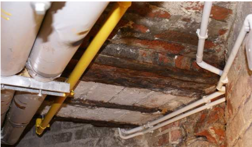
Rys. 7. Nadproże w przejściu przez ścianę fundamentową
