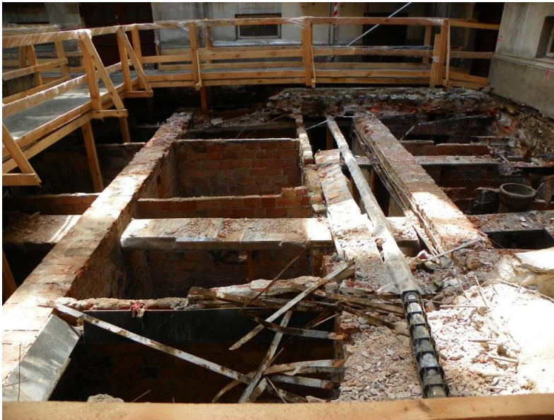
Rys. 11. Widok podwórka w trakcie prowadzenia robót rozbiórkowych stropu
